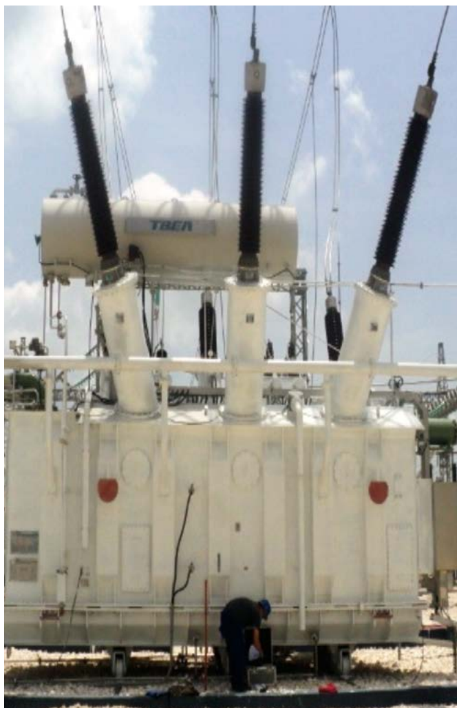
Figura 8. Autotransformador 125 MVA 220/110/11 kV.
