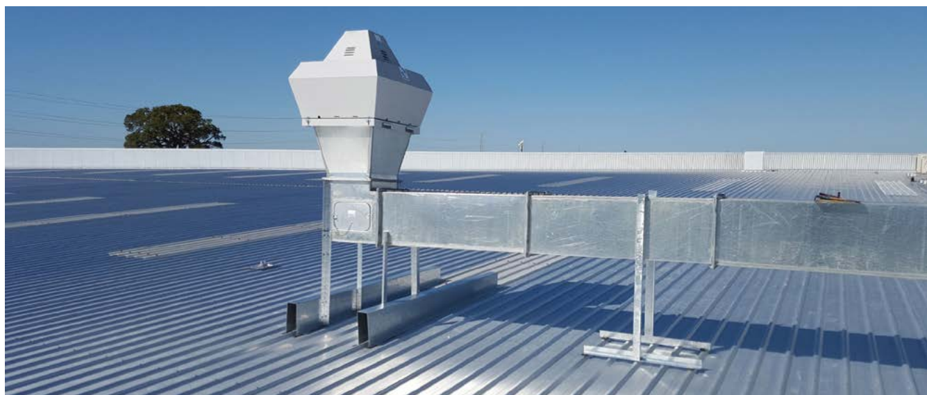
Sistema de refrigeración en un centro comercial. Foto: Pixabay.
